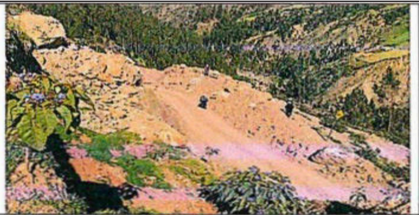
Imagen n.º 25: Movimiento de tierra producto de los deslizamientos.
