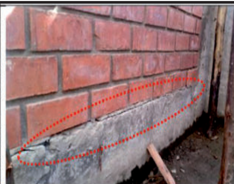
En la imagen se observa una junta fría entre el muro de ladrillo y el sobrecimiento.
