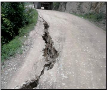
al mediodía del pasado martes 07 de marzo, que una parte de la plataforma de la carretera que conduce a los distritos de Ponto, Chaná, Llata, viene presentando raiaduras en la plataforma, el punto exacto a 100 metros de Palca.
